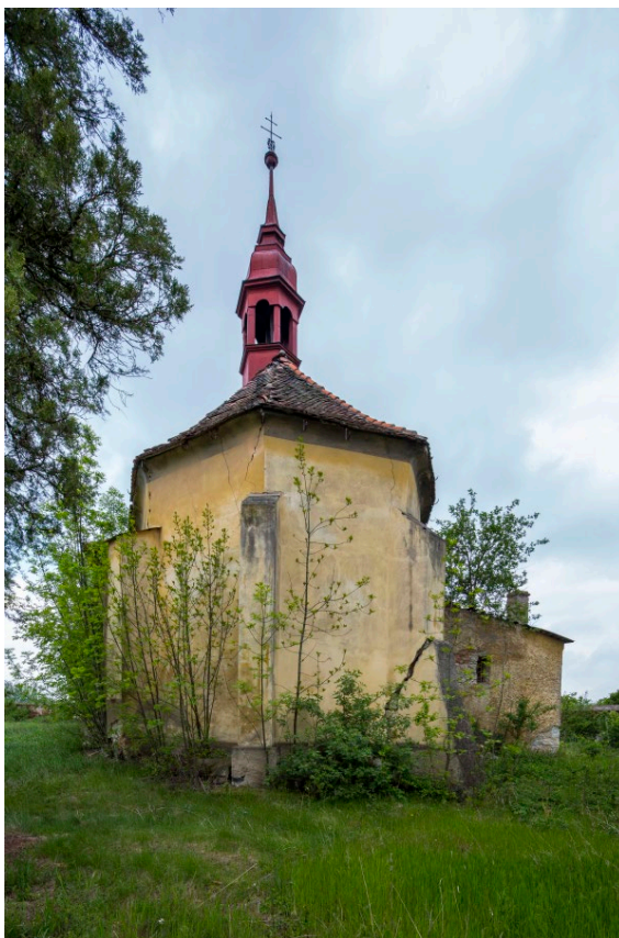
Východní průčelí presbytáře v pohledu od východu. Foto: Marta Pavlíková 2019.
