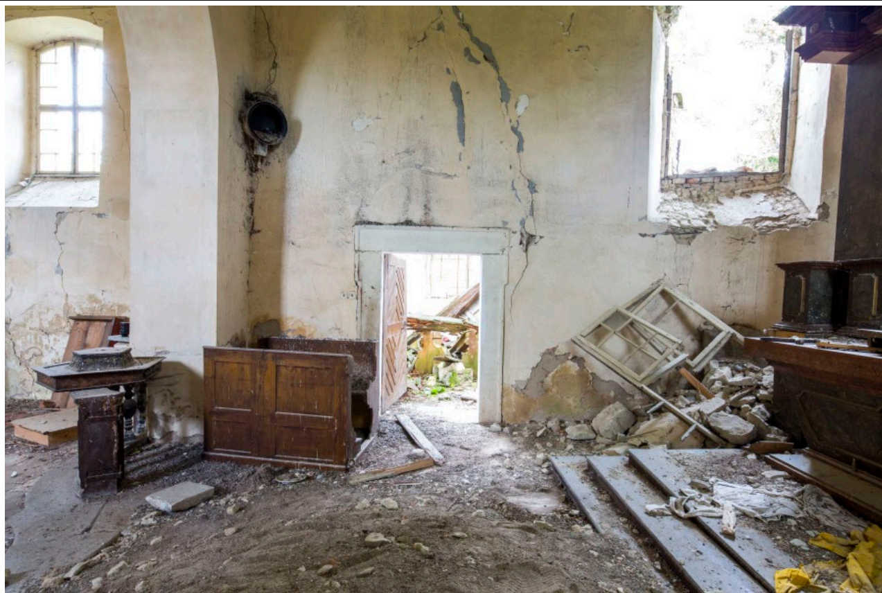
Severní stěna presbytáře se vstupem do sakristie v pohledu od jihu. Foto: Marta Pavlíková 2019.
