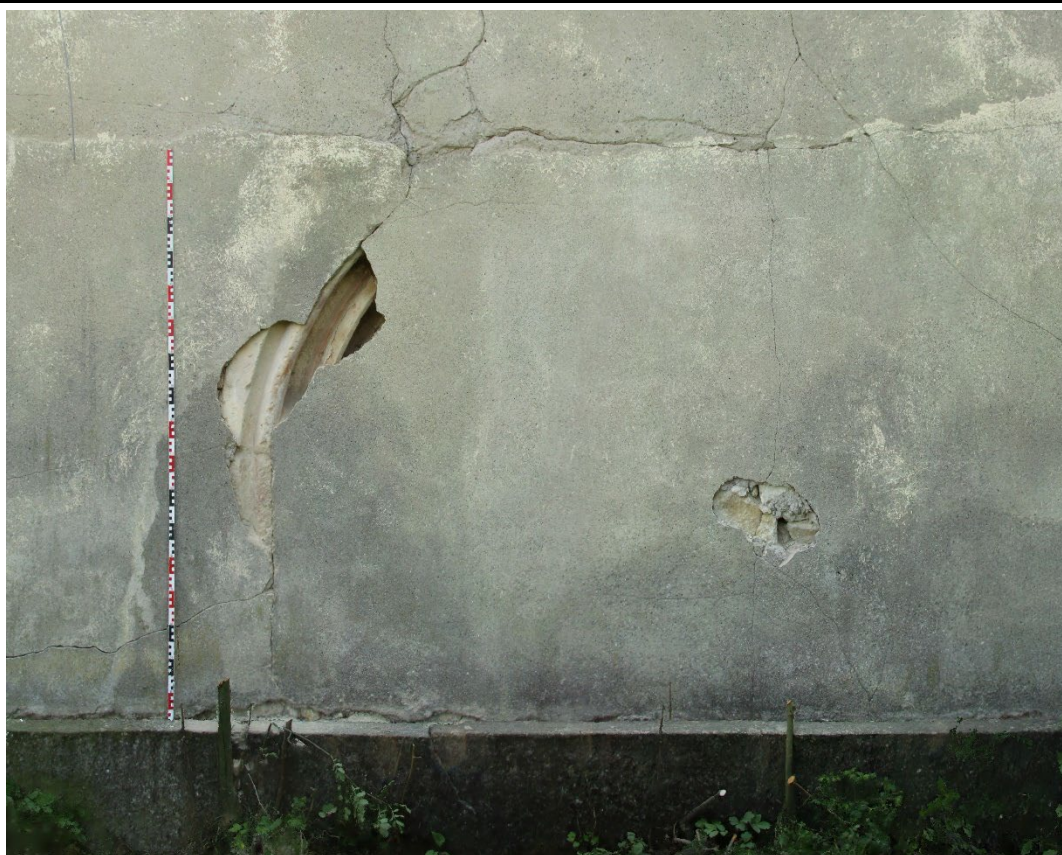
Detail zazděného gotického portálu v ose severního průčelí lodi. Foto: Jaroslav Skopec 2019.
