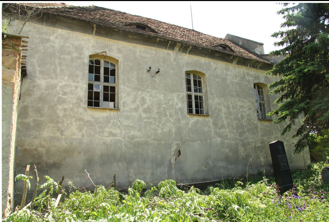
Severní průčelí lodi v pohledu od severu se zazděným gotickým portálem v ose stěny. Foto: Jaroslav Skopec 2019.
