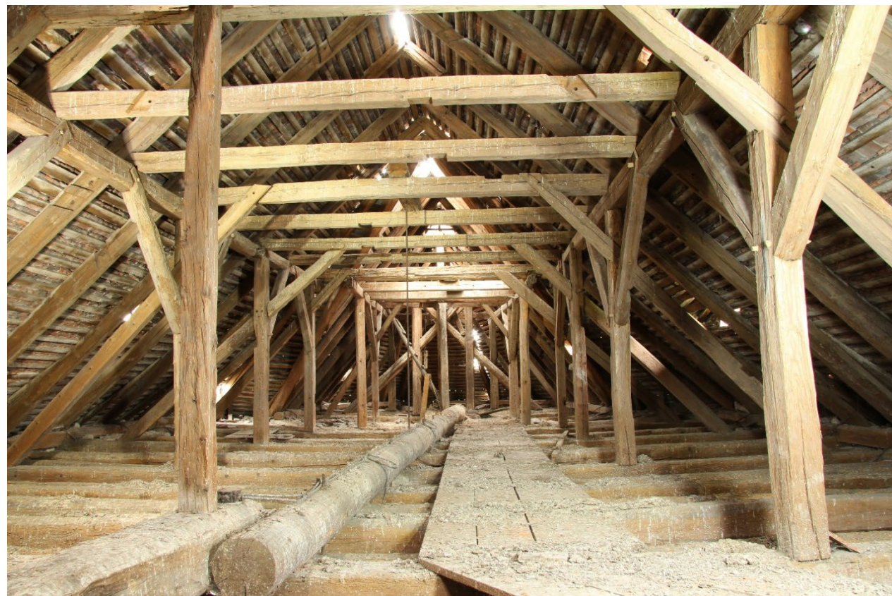
Průhled krovem nad lodí k východu. Na hambalku v popředí jsou patrné dlaby dokládající jeho druhotné využití ze starší konstrukce krovu, pro nějž bylo dřevo kácené v sezóně 1545/46. Foto: Jaroslav Skopec 2019.
