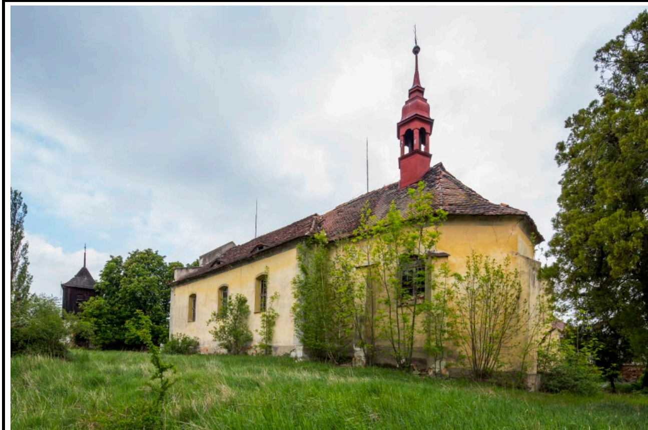
Celkový pohled od jihovýchodu. Foto: Marta Pavlíková 2019.
