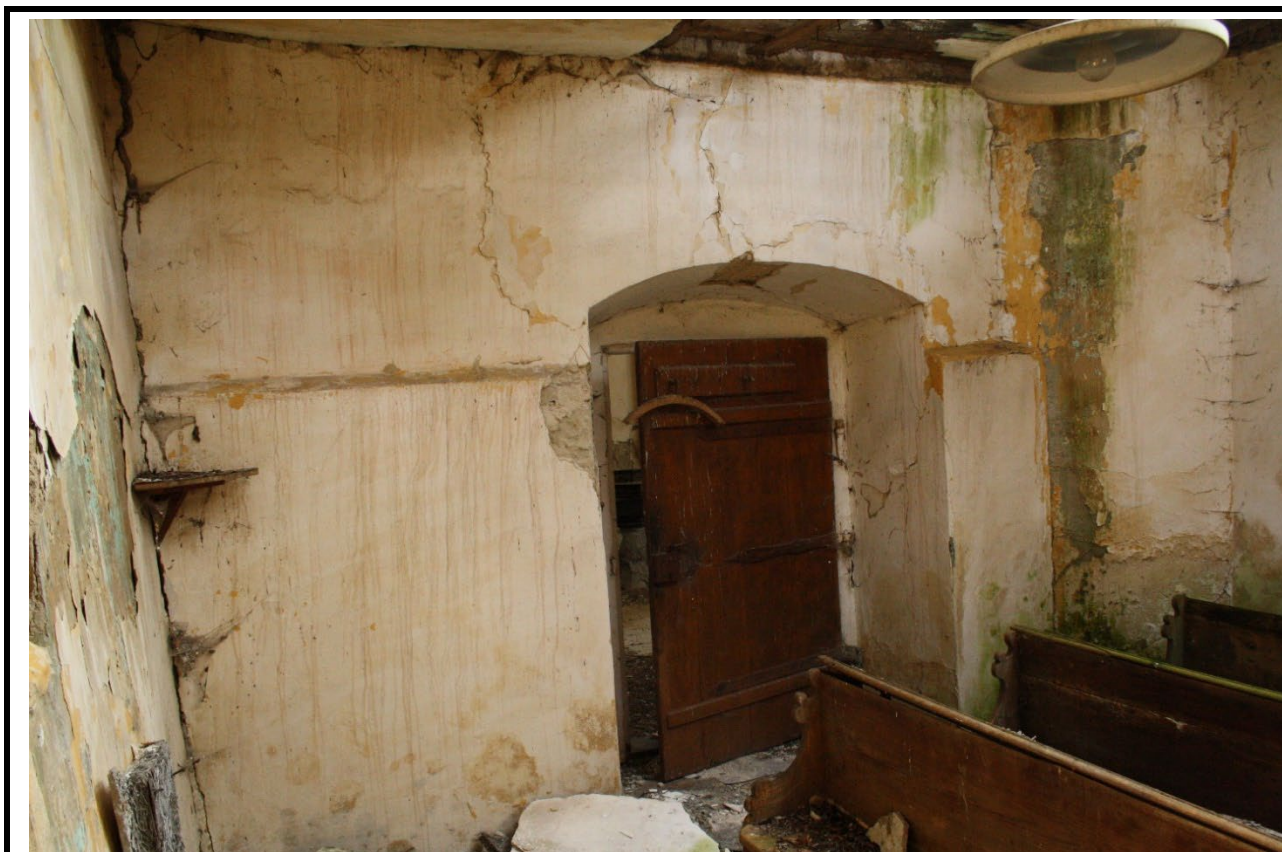
Jižní stěna sakristie v pohledu od severu. Foto: Jaroslav Skopec 2019.
