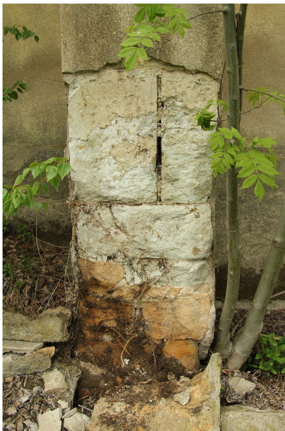
Detail odhaleného armování jižního opěrného pilíře presbytáře. Foto: Jaroslav Skopec 2019.
