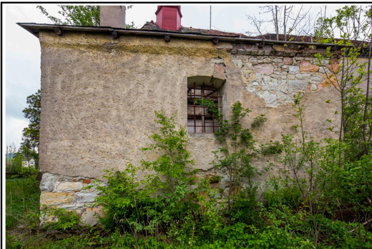
Severní průčelí sakristie v pohledu od severu. Foto: Jaroslav Skopec 2019.
