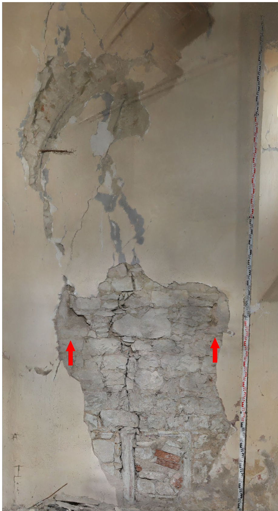
Jihovýchodní stěna závěru presbytáře v pohledu od severu. Dole se nachází druhotně osazené ostění náležející s největší pravděpodobností sanktuáriu. Šípkami jsou vyznačeny dochované fragmenty parapetu a stojek ostění gotického okna. Oblouk vlevo nahoře náleží mladšímu okennímu otvoru. Dole je patrné v druhotné poloze zazděné ostění sanktuária. Foto: Jaroslav Skopec 2019.
