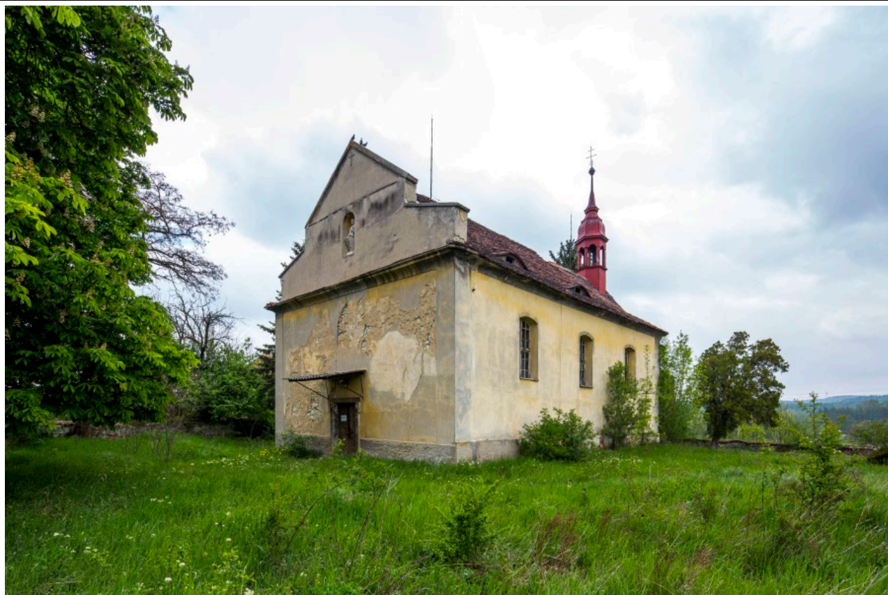
Celkový pohled od jihozápadu. Foto: Marta Pavlíková 2019.
